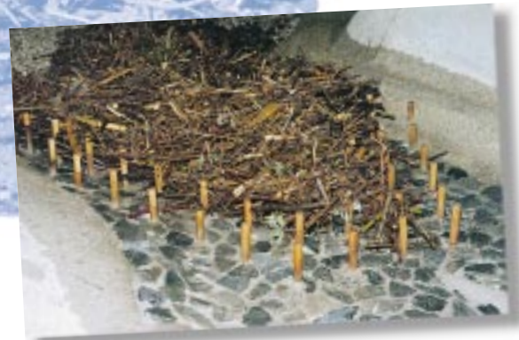
Camping-Katastrophe: Mehr als 70 Menschen fanden auf dem Campingplatz Las Nieves den Tod. Bild unten: V-förmige Konstruktionen halten Wildholz zurück, erhöhen die Sicherheit.
