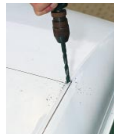
Gebohrt: Zum Einsetzen der Säge bohrt man in den Ecken des Ausschnitts Löcher.
