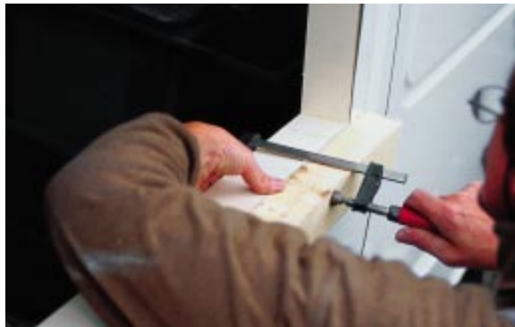
Gespannt: Der Holzrahmen für das Seitz-Fenster wird zum Verkleben mit Schraubzwingen angepreßt.
