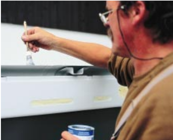
Gestrichen: Die Ausschnittkante wird nach dem Glätten mit Rostschutzfarbe gestrichen.
