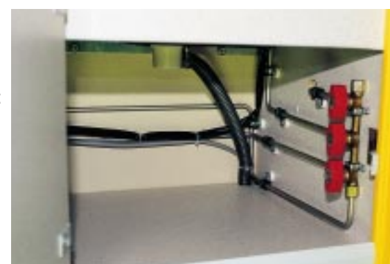
Geteilt: Der Verteiler- block für drei Entnahmestellen (rechts) ist fest mit Schellen verschraubt.
