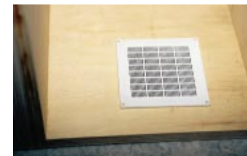
Gelüftet: Die Entlüftungs- öffnung im Gas- flaschenkasten muß mindestens 100 cm² groß sein (oben).
