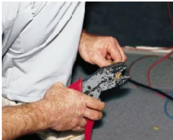
Gesteckt: Kabelverbinder werden mit der Quetschzange befestigt.
