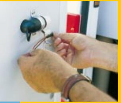
**5** Austrittswinkel samt integriertem Lüftermotor durch Außenwand schieben, innen mit Winkeln verschrauben, Elektrokabel anschließen.
