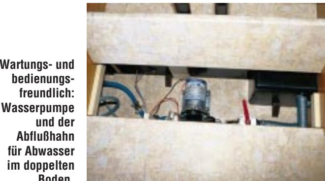
Wartungs- und bedienungsfreundlich: Wasserpumpe und der Abfluss für Abwasser im doppelten Boden.
