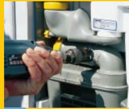
**1** 35 mm-Loch in den Ausgußstutzen bohren. Gummitülle einsetzen. Anschlußwinkel einsetzen, anpassen, ablängen und einkleben.
