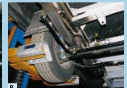
8. Fertig: Der Stabilisator ist montiert und kann seine ausgleichende Arbeit aufnehmen.
