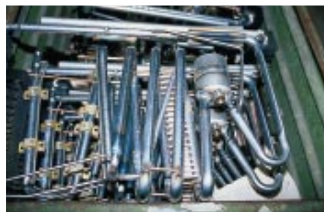
Isoliert: Jedes einzelne Aggregat erhält einen schützenden Mantel, der vor Kälteverlust schützt.
