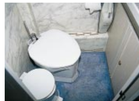
Sanitärtrakt. Das Bad ist mit fest installierter Zerhackertoilette ausgerüstet.
