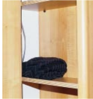
Die Elektroleitung im Fächerschrank ist lose verlegt.
