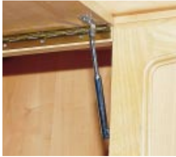
Die Hängeschränke sind mit Klavierband und robusten Metallaufstellscheren ausgestattet.
