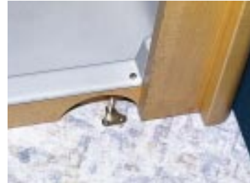
Der Metallschließzapfen der Badezimmertür sitzt unter dem Türrahmen.
