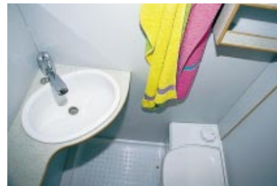
Wasserfest: Badeinbauten aus Multiplexplatten.
