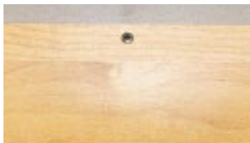
Nicht abgedeckte Möbelschrauben im Wohnbereich.
