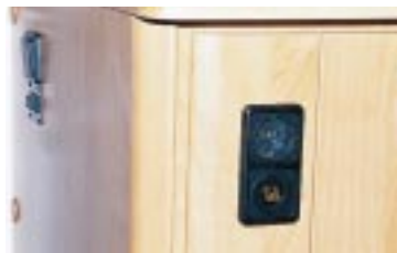
Nicht abgedeckte Elektroanschlüsse unter der Küchenspüle.
