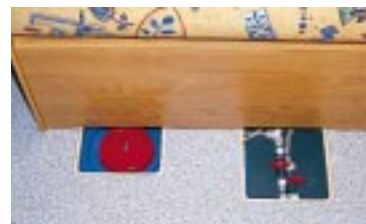
Die Wasseranlageninstallation wird über Serviceluken gewartet.
