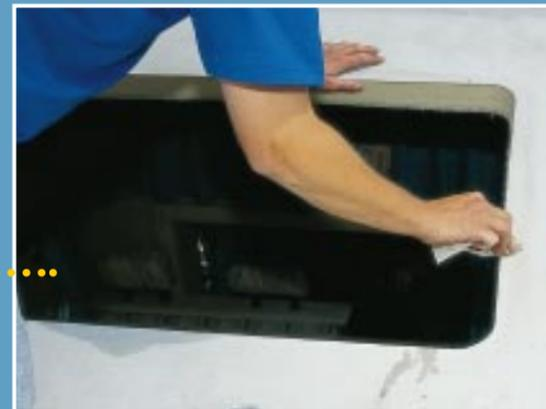
**4** Um unser Dach nicht zu zerkratzen, kleben wir es außerhalb des Sägeschnittes mit einem breiten Gewebeklebeband ab.
