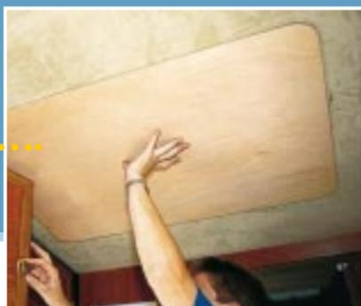
**5** Mit einer Stichsäge läßt sich das 50 Millimeter starke Sandwichmaterial gut bearbeiten. Schnell ist der benötigte Ausschnitt geschaffen.
