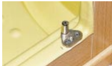
Der Schließzapfen ragt in den Badezimmer-Türrahmen.
