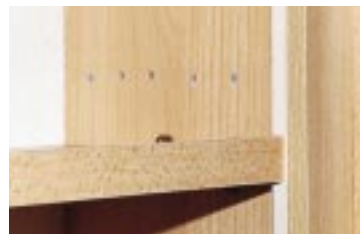
Nicht abgedeckte und unordentlich eingedrehte Spax-Schrauben.
