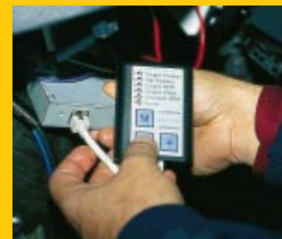
9 Abschließend programmiert der Monteur die Steuereinheit für das Fahrzeug. Er kann sie sogar an den Fahrstil des Kunden anpassen.
