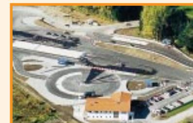
Areal bietet Gleitfläche, Asphalt-Dynamikfläche, Kreisbahn mit 50 Meter Durchmesser, eine steile Strecke mit sieben Prozent Gefälle und Gleitfläche sowie Aquaplaningbecken.
