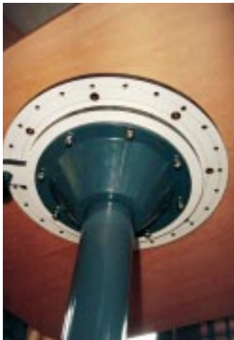
Geklemmt: Unter die Bodenklappe geschraubte Holzleisten greifen unter Gegenstücke im Boden.
