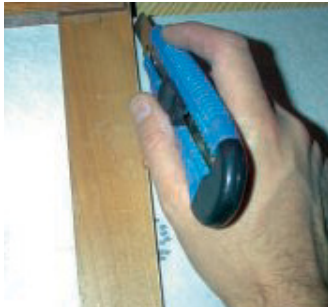
Die Isolierplatten lassen sich mit einem Teppichmesser gut schneiden.
