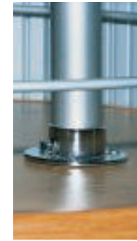
Nachlässig eingedrehte Schrauben.
