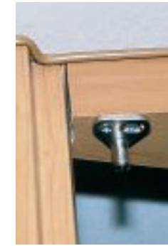
Schlecht eingepasster Sturz über der Badezimmertür.
