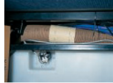
Unzugänglicher Ablasshahn für Frischwasser.
