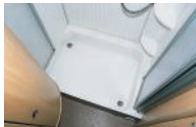
Die Duschwanne verfügt über zwei Abläufe.
