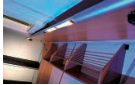
Alustäbe als Fachböden, Leuchten sind in den Klappenabschluss integriert.
