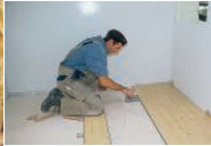
Eingeklebt: Verlegen eines Laminat-Fußbodens in eine Kabine (links), Blick in die Montagehalle (rechts).
