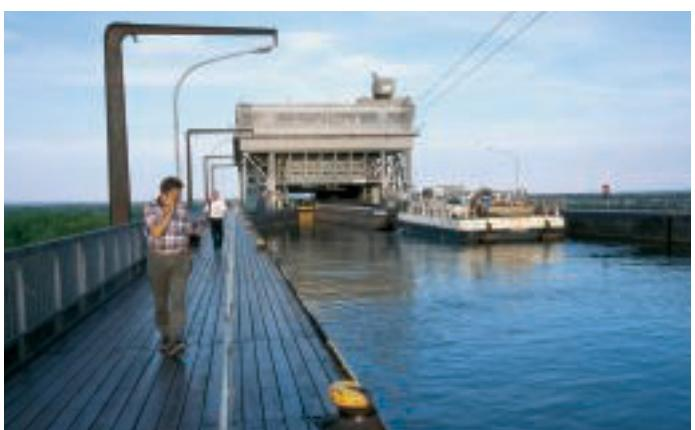
*Ein Schubverband muss entkoppelt werden, das alte Werk ist zu klein.*
