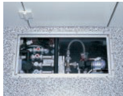
Druckwasserpumpe und Wasserregler sind im doppelten Boden untergebracht.
