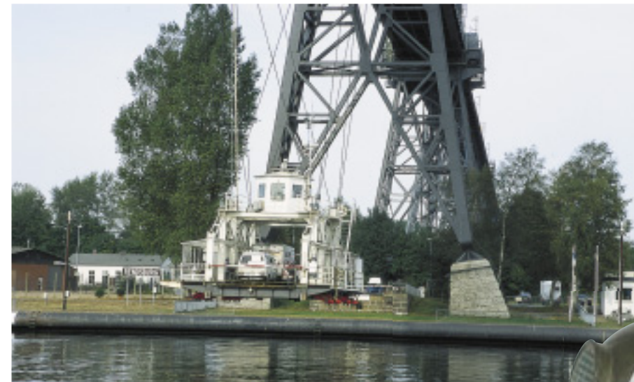
Einmalige Konstruktion: Die Schwebefähre hängt an zwölf Stahlseilen unter der Eisenbahnhochbrücke von Rendsburg. Erbaut zwischen 1911 und 1913, wiegt die Brücke 17.000 Tonnen.
