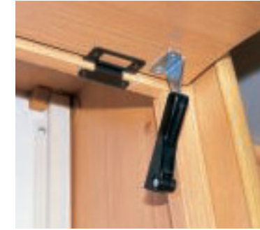
Die einfachen Aufsteller der Hängeschränke sind etwas schwach ausgefallen.
