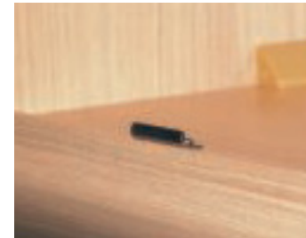
Die Metallschließbleche der Hängeschränke ragen aus dem Rahmen.
