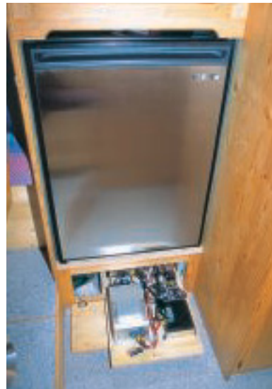
Zum Kühlen und Warten: Die Elektrozentrale liegt unter dem Kühlschrank.
