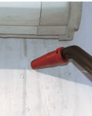
Die geballte Kraft des Wasserdampfes ist an den berüchtigten Regenstreifen zu erkennen: Sie verschwinden. Diese Gewalt gebietet andererseits Vorsicht an dauerelastischen Dichtmassen und am Dekor.
