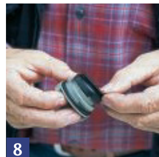
8 Ventildichtung tauschen und den Träger samt Schwimmer wieder einhängen.
