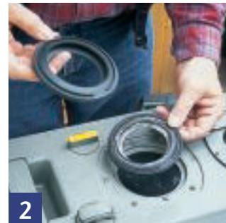
2 Dichtung herausheben, austauschen und Abdeckplatte wieder verschrauben.
