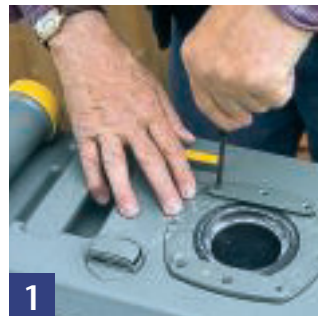
1 Zuerst Schieber entfernen, die acht Schrauben der Abdeckplatte lösen und Platte abheben.
