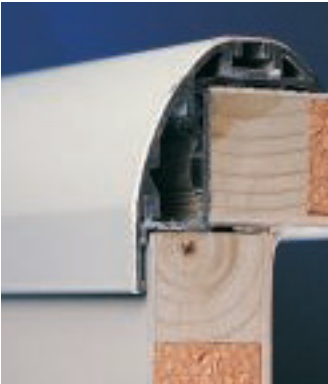
Design, unterschiedlich gelöst: Niesmann+Bischoff verklebt die geschlitzten und umbogenen Sandwichplatten überlappend (links), EuraMobil benutzt ein zweiteiliges Eckprofil (Mitte), Laika klebt ein Rundprofil über die verschraubten Teile.
