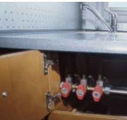
Angenehm platziert: die Gas-Absperrhähne direkt unter der Spüle.
