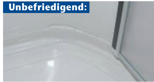
Die Duschwanne ist nicht komplett verfugt.
