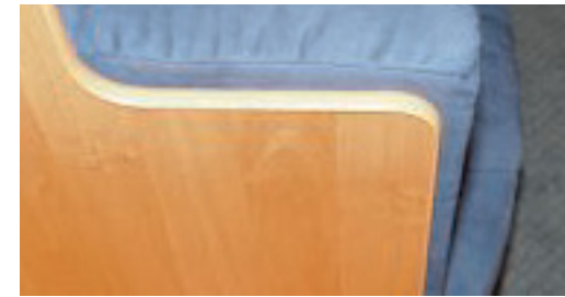
Einfache Kunststoffumleimer an den Möbelkanten.
