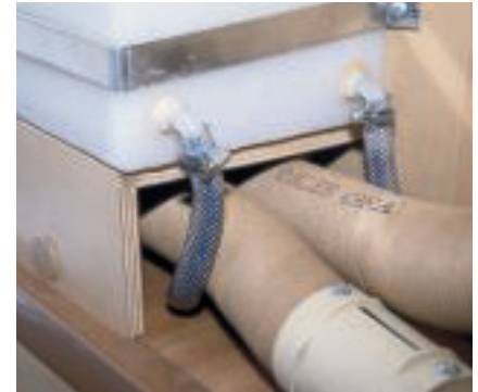
Die Stützen der Tanks sitzen zu hoch. Sie lassen sich damit nicht vollständig entleeren.
