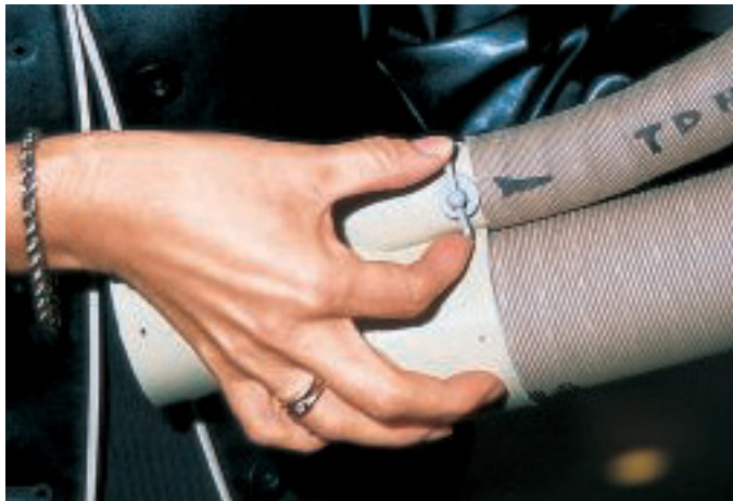
Unterschiedliche Rohrdurchmesser und einstellbare Drosselklappen regeln den Luftdurchfluss in den Rohren der Luftheizung.
