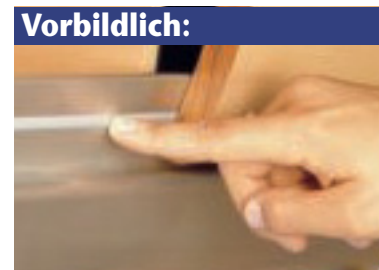
Vorbildlich: Eine Gummilippe verhindert das Klappern der Türen.
