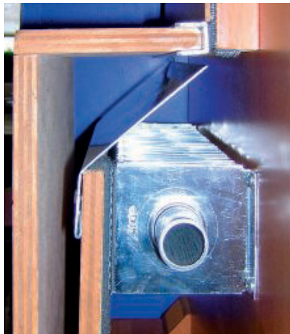
Leitbleche führen die von den Konvektoren erhitzte Luft hinter die Möbel und verhindern einen Wärmestau.
