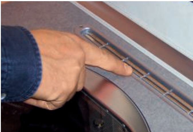
Die bei einer Wasserheizung konsequent erforderliche Hinterlüftung der Möbel macht auch vor dem Küchenblock nicht Halt.
