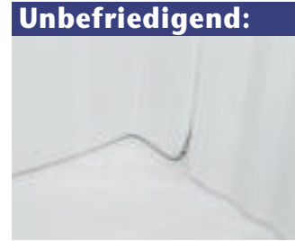
Die Duschkabine ist überhaupt nicht verfugt.
