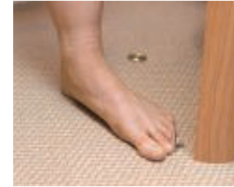
Der Schließbolzen im Boden des Bades ragt in den Durchgang.
