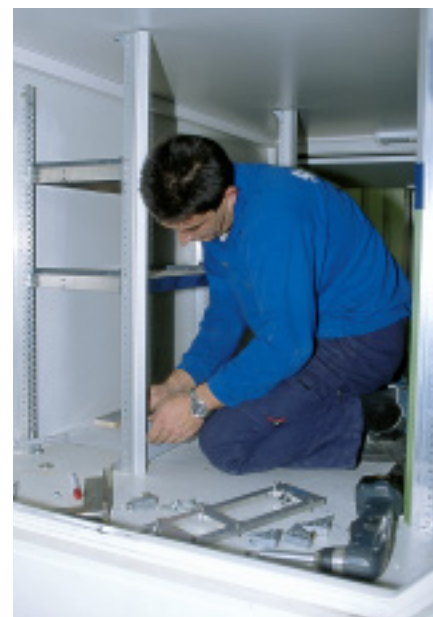
Verschraubt: Zum Teil in der Werkstatt vormontiert, passt der Techniker die Alu-Module exakt in die Heckgarage ein.
