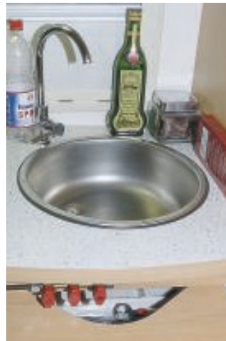
Durchdacht: gut erreichbare Gasabsperrhähne, hoher Wasserhahn.
