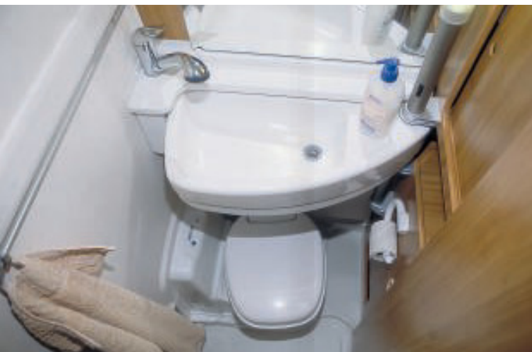
Drehbar: Um mehr Bewegungsfreiheit in der Nasszelle zu erhalten, lässt sich das Waschbecken wegschwenken.
