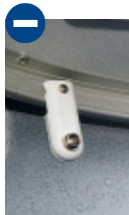
Zu schwache Halterung der Duschtüren.
