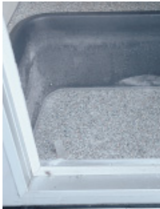
In der unisolierten Trittschale bildet Schwitzwasser sogar Eisstalamitten.
