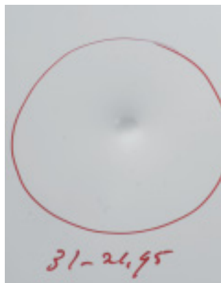
Die 20-Millimeter-Kugel schlägt in das Dach mit verklebtem Alublech eine 1,34 Millimeter tiefe Delle.
