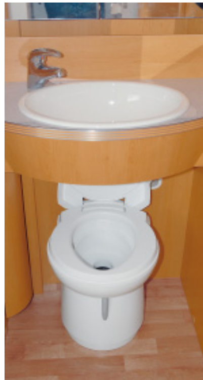
Der Waschbeckenlift ist eine ebenso Platz sparende wie überzeugende Lösung. Mit einer Hand lässt sich das Becken nach oben oder unten schieben.
