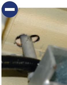
Der Durchbruch des Gurtbocks ist nicht abgedichtet.
