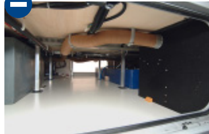
Viele Leitungen liegen im Doppelboden völlig ungeschützt.
