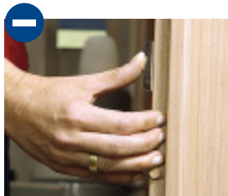
Scharfkantiges Metallschließblech der Badezimmertür ragt aus dem Rahmen.
