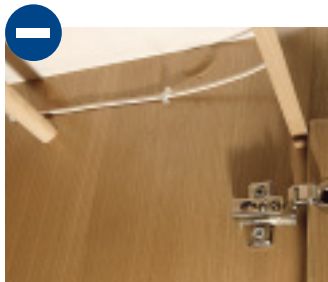
Die Elektrokabel wurden nicht vollständig in Kabelkanälen verlegt.
