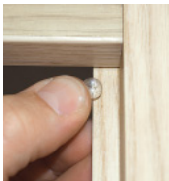
An vielen Möbelklappen fehlen Anschlagpuffer oder sie sind falsch aufgeklebt. Mit ihnen liegen Klappen und Türen sauber an.
