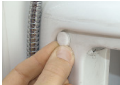
Selbstklebende Filzgleiter – hier an der Abdeckung der Duscharmatur – unterbinden Geräusche an den Kunststoffteilen der Nasszelle.
