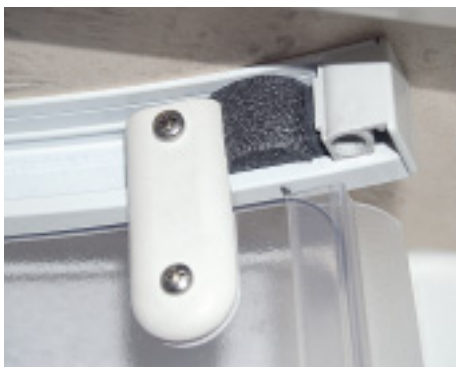
Aus der halbierten Scheibe einer Rohrisolierung entsteht ein federnder Anschlagpuffer, der die Duschwand auf Spannung hält und Geräusche dämmt.
