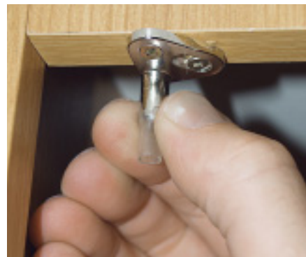
Ein Stück Aquariumschlauch auf dem Schließzapfen des Drehstangenschlosses mindert das Spiel des Schließhakens.
