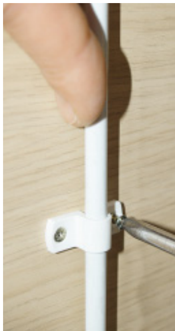
Ein Stück Aquariumschlauch auf dem Schließzapfen des Drehstangenschlosses mindert das Spiel des Schließhakens.
