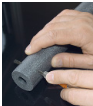
Aus der halbierten Scheibe einer Rohrisolierung entsteht ein federnder Anschlagpuffer, der die Duschwand auf Spannung hält und Geräusche dämmt.
