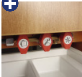
Die Gasabsperrhähne sind leicht bedienbar installiert.
