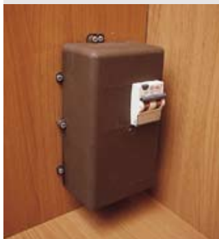
Bürstner stattet die Möbel des Viseo mit stabilen Teleskopaufstellern aus, die Außenspiegel des Integrierten aber ohne Weitwinkelapplikationen. Der FI-Hauptschalter steht ungeschützt im Kleiderschrank (v. o. n. u.).
