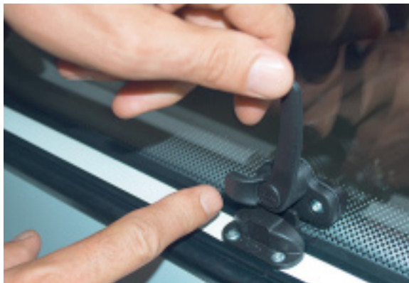
Die Knebel an den Fenstern hält Polizist Busch für zu schwach, selbst mit Riegel.
