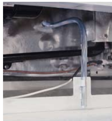
Ein verlängerter Abwasserschlauch führt Kondenswasser gleich nach draußen ab.
