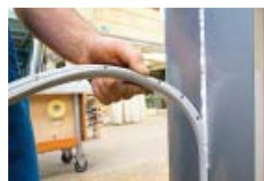
**Der spannungsfreie Einbau der Eingangstür und das millimetergenaue Anbringen der Dekorfolie sind immer wieder ganz besondere Herausforderungen. Das penible Entfernen von Silikonresten, das Fixieren der neuen Wand, die Montage der Anbauteile und das Einsetzen der Dichtung sind dagegen Routine.**
