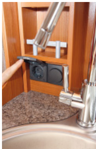
Nahe am Wasser gebaut: Die 230-Volt-Steckdose der Küche sitzt im Spritzwasserbereich des Hahns.
