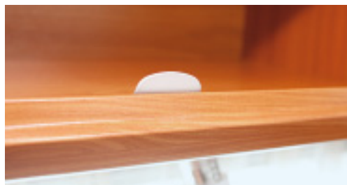
Herausragend: Die großen Metallschließbleche der Oberschränke ragen aus den Rahmen. Sie sind abgeschliffen, stoßen kann man sich aber dran.
