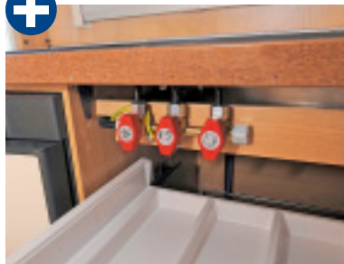
Die Gasabsperrhähne wurden in Stehhöhe und in der Besteckschublade montiert.
