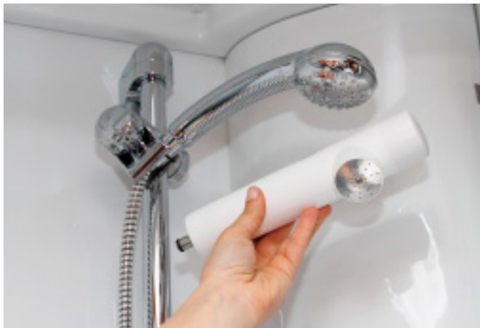
Der Duschkopf von Aqua Free lässt keine Legionellen passieren. Ein Adapter wird am Schlauch verschraubt, der Wechsel gelingt im Handumdrehen.
