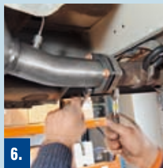
6. Letzte Kontrolle des Drehmoments. Der Filter sitzt eingebunden in die Originalauspuffanlage fertig am Unterboden. Der Monteur schließt damit den Einbau der Hardware ab.
