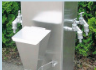
Nicht gut: Ausguss für WC-Kassette und Frischwasser nebeneinander.
