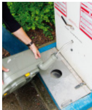
Bild links: So bitte nicht. Der große Deckel sollte zum Entleeren der Kassette geöffnet werden. Bild oben: Die Kassette kann am Spülrohr kostenlos gespült werden.
