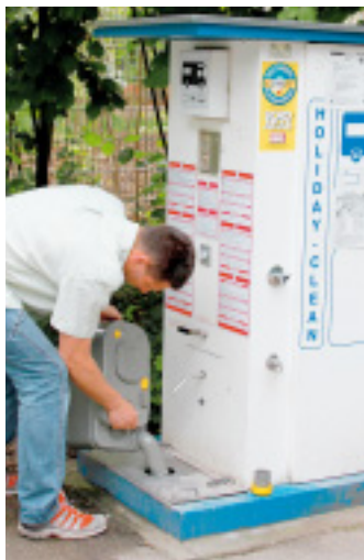
Bild links: So bitte nicht. Der große Deckel sollte zum Entleeren der Kassette geöffnet werden. Bild oben: Die Kassette kann am Spülrohr kostenlos gespült werden.
