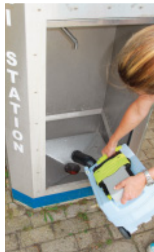
Pfiffig gelöst: Weit entfernt vom Frischwasseranschluss öffnet sich der Rollladen und gibt den Schacht frei. Das Spülen würde etwas einfacher gelingen, wenn das Spülrohr weiter vorn platziert wäre.
