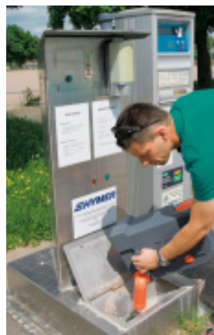
Standard: ein Ausgusschacht in Bodennähe. Sehr hilfreich: Beleuchtung und eine, wenn auch knappe, Bedienungsanleitung.
