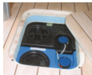
Die Installation und die Wassertanks liegen im gut isolierten Doppelboden.
